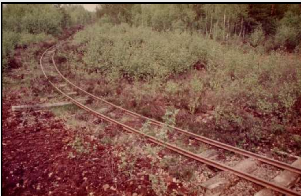
Järnvägen mellan mossen och Porla Torvfabrik
