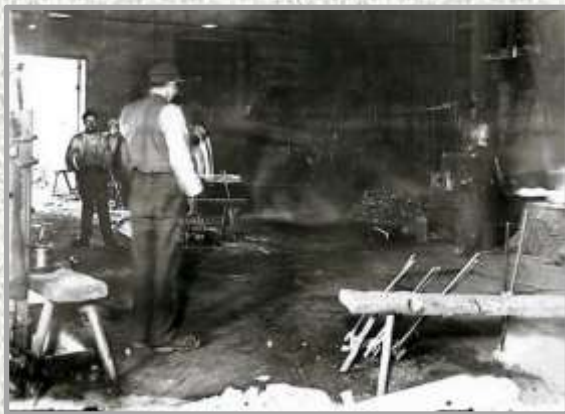
Interiör från Stångjärnshammaren
