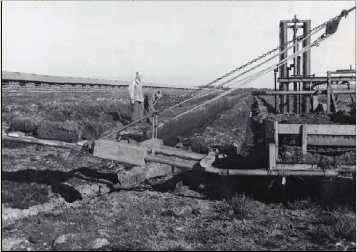
Förman August Ekman vid Linds grävmaskin, 1952
