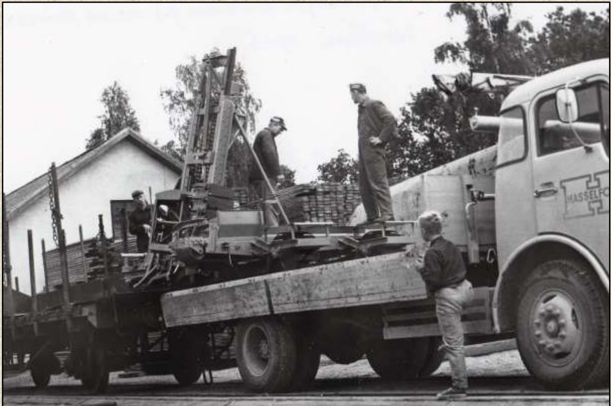
Lossning av två stycken grävare "Digger 65", Stockås, hösten 1965
