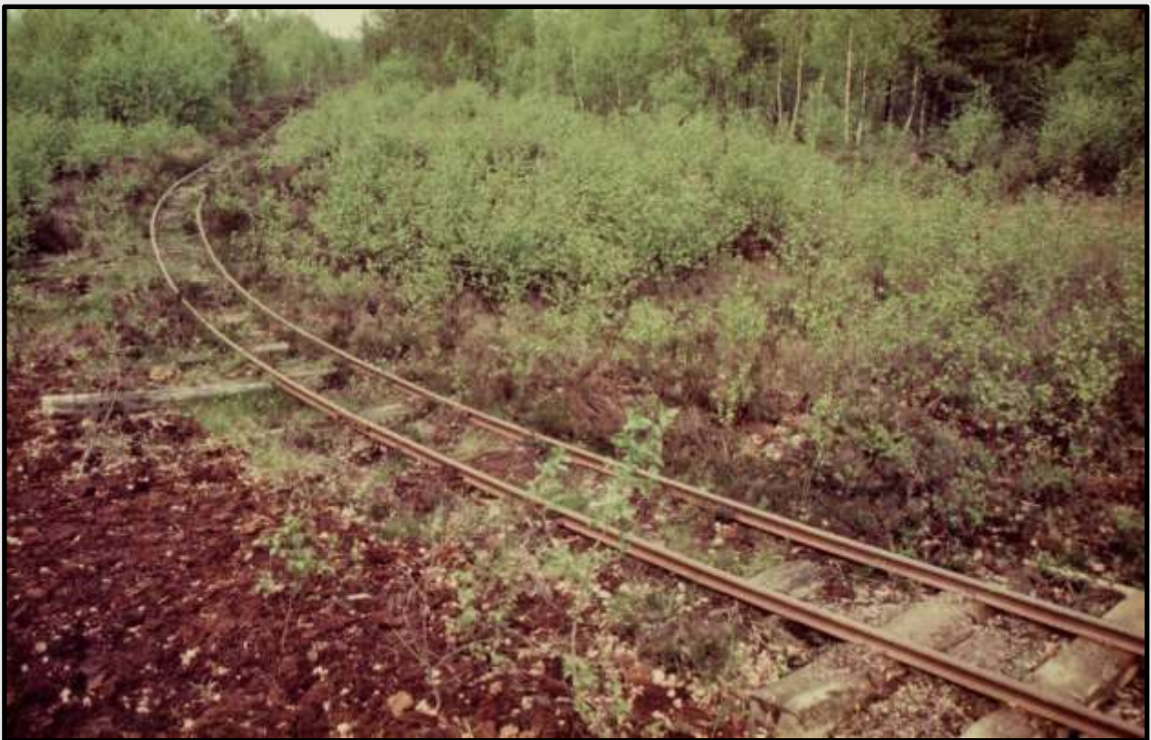
Järnvägen mellan mossen och Porla Torvfabrik
