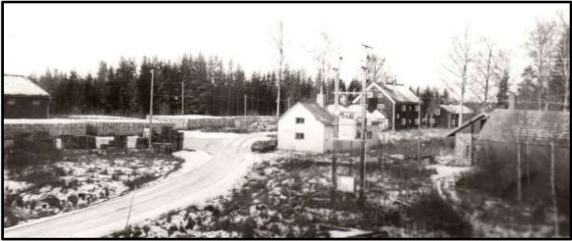
Kontor och personalutrymmen. Till höger är lokstallet, byggt av slaggsten. I bakgrunden syns personalbostäder.
