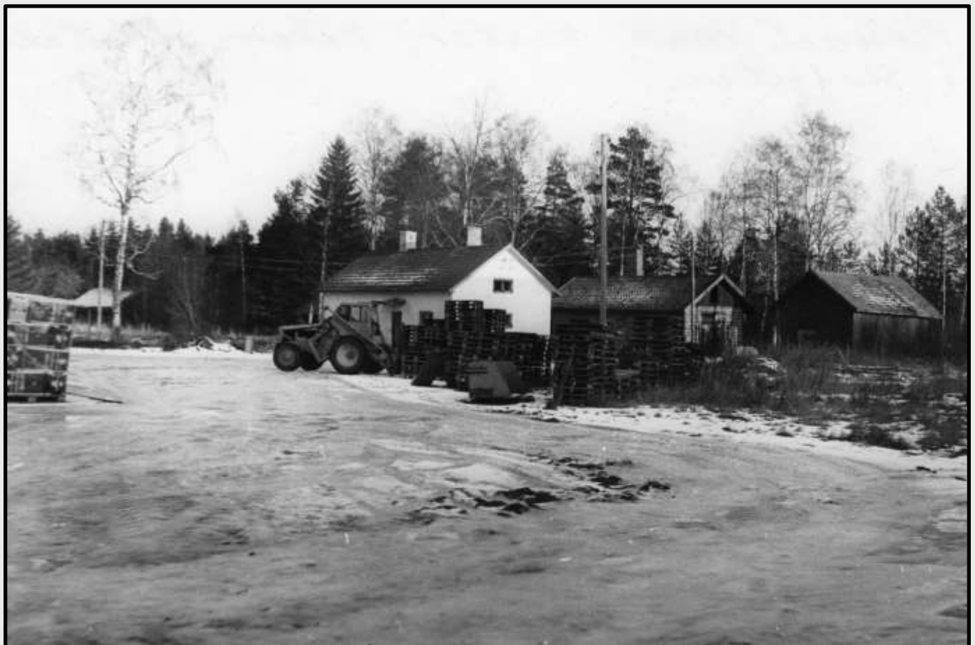
Kontoret med personalutrymmen, i bakgrunden lokstallet.
