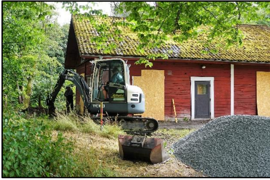
Schaktning och dränering vid brygghuset, augusti 2020
