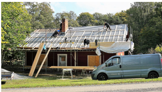
Taket läktas, TB Snickarservice
