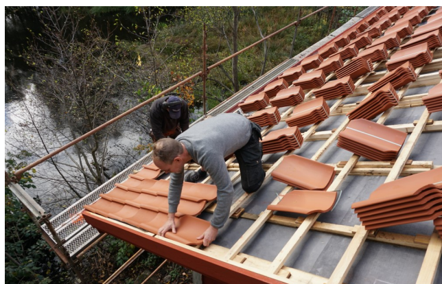
Christer Lövback, TB Snickarservice, lägger taktegel
