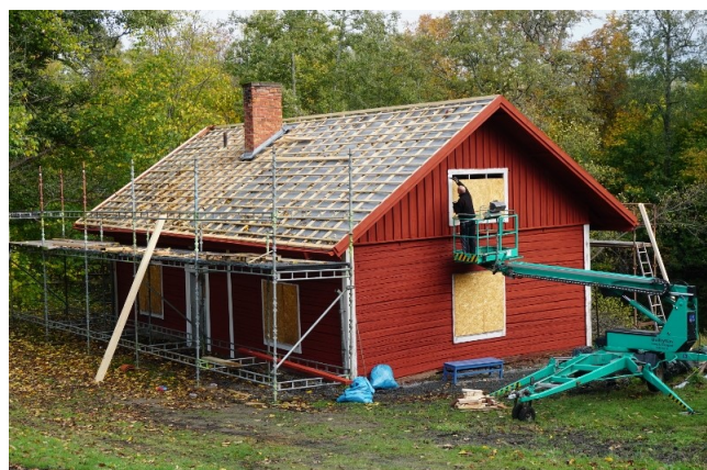
Benny rödfärgar och målar runt fönster
