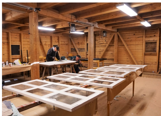
Rune och Per målar fönster och dörrar
