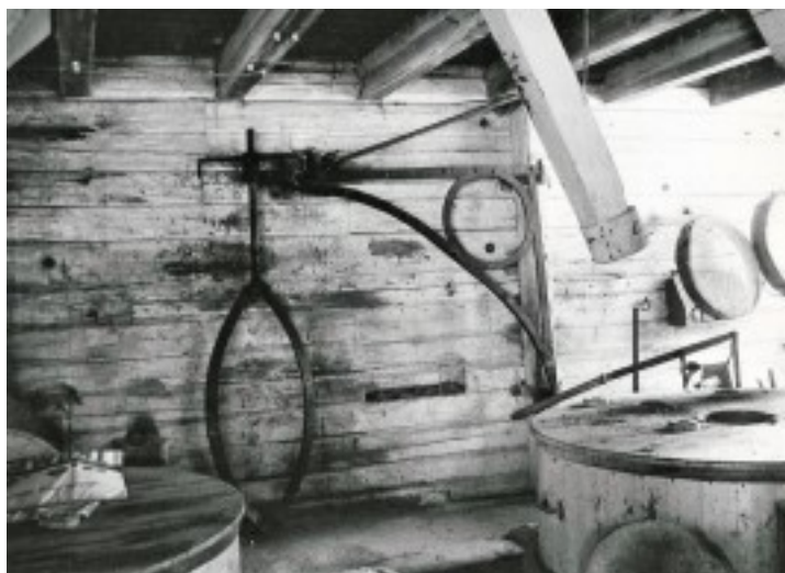
Lyftanordning för kvarnstenar.
