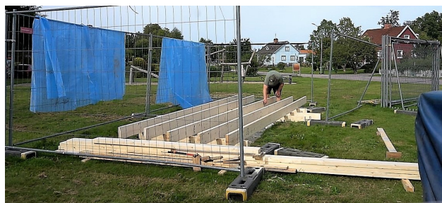
Stand out XPO AB – Jerker Reinholdsson jobbar med polering av det rostfria stålet och Mikael Jakobsson med uppbyggnad av bottenplattan.
