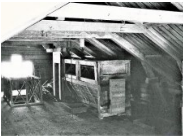
Säckarna med säd vinschades upp via de övre dörrarna på kvarnen.
