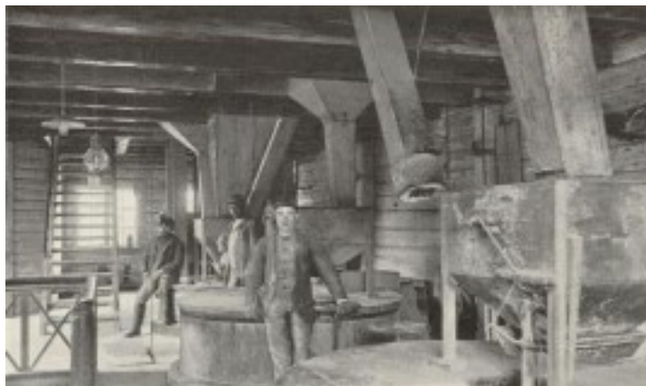
Kvarnhuset byggt i två våningar, den undre våningen av huggen gråsten och den övre av timmer. Trappan leder upp till vindsvåningen, dit säden vinschades upp via ett spel på utsidan av kvarnen.
